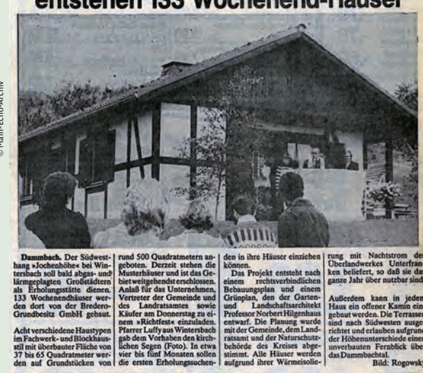
Nach fast zehnjähriger Planungs-, Genehmigungs- und Bauzeit wurden im Sommer 1980 die ersten Häuser der Wochenend- und Feriensiedlung »Jochenhöhe« bei Wintersbach eingeweiht.
